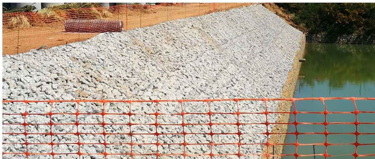
Imagem n.º 23 – exemplo de execução de gabião tipo colchão Reno (foto gabiões Reis).
