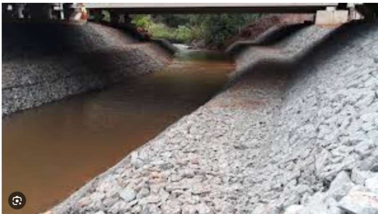
Imagem n.º 22 – exemplo de execução de gabião tipo colchão Reno (foto gabiões Reis).
